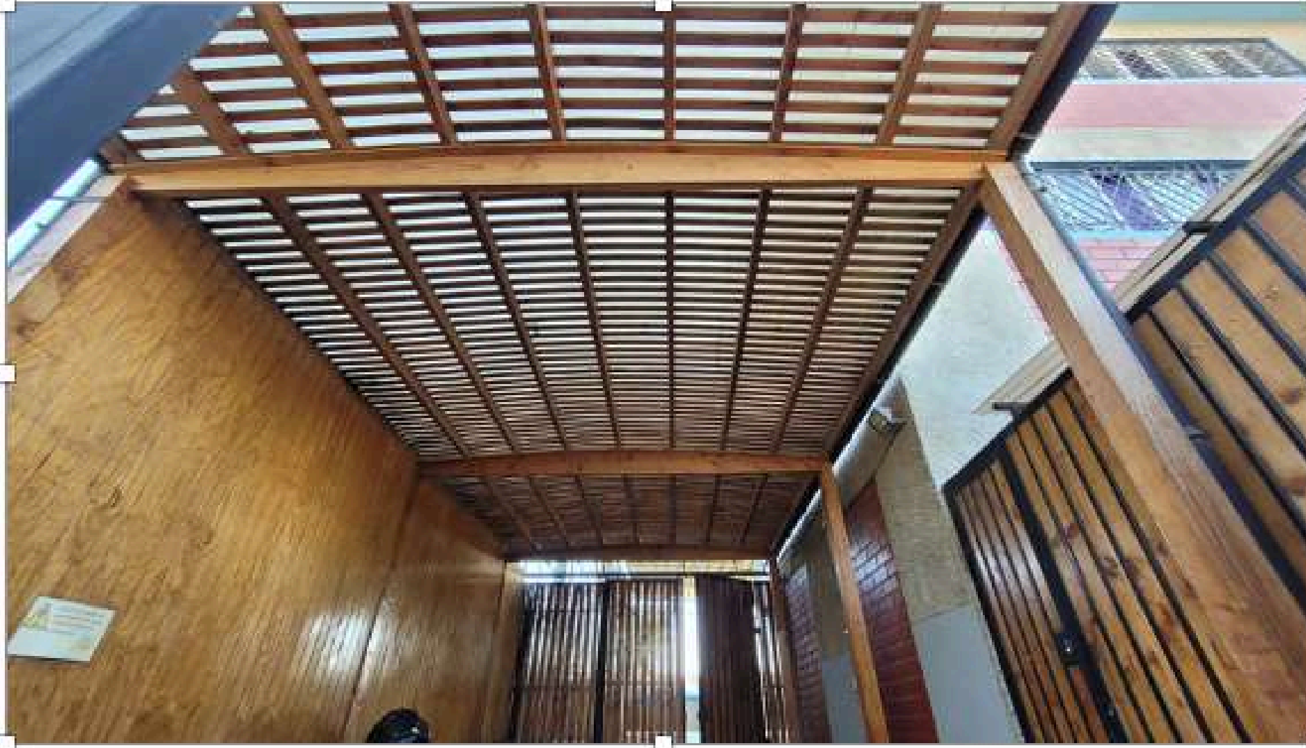
⚓ Techado Entrada Edificio anexo
